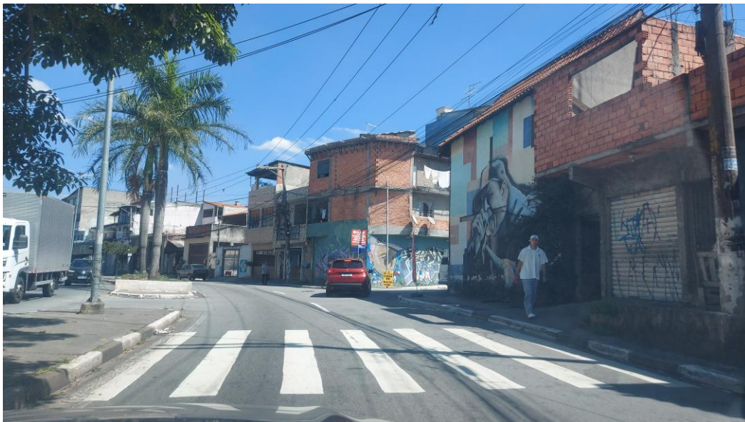
Figura 20. Vista da Avenida Marginal do Cadaval, onde se vê edificações de até 3 pavimentos. Foto: Geopixel, 2026.
