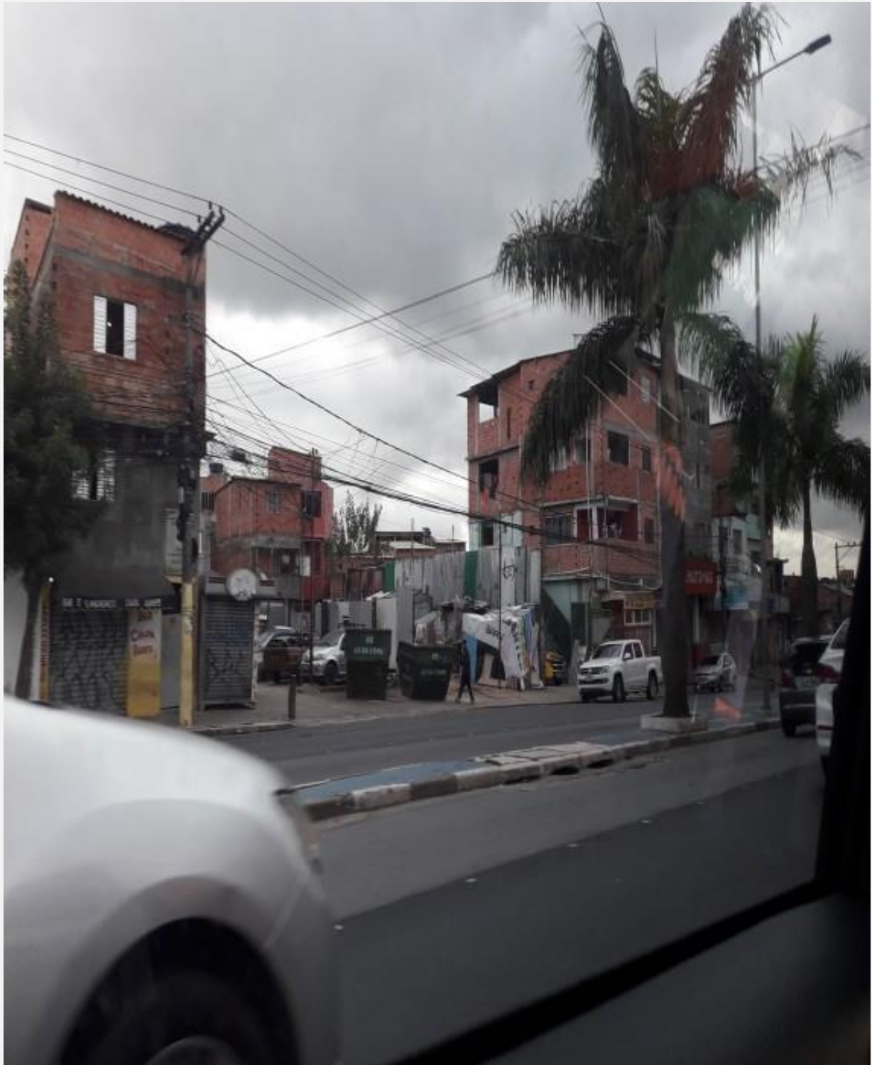
ÁREA PASSÍVEL DE INCÊNDIOS, DESLIZAMENTOS E ENXURRADAS
