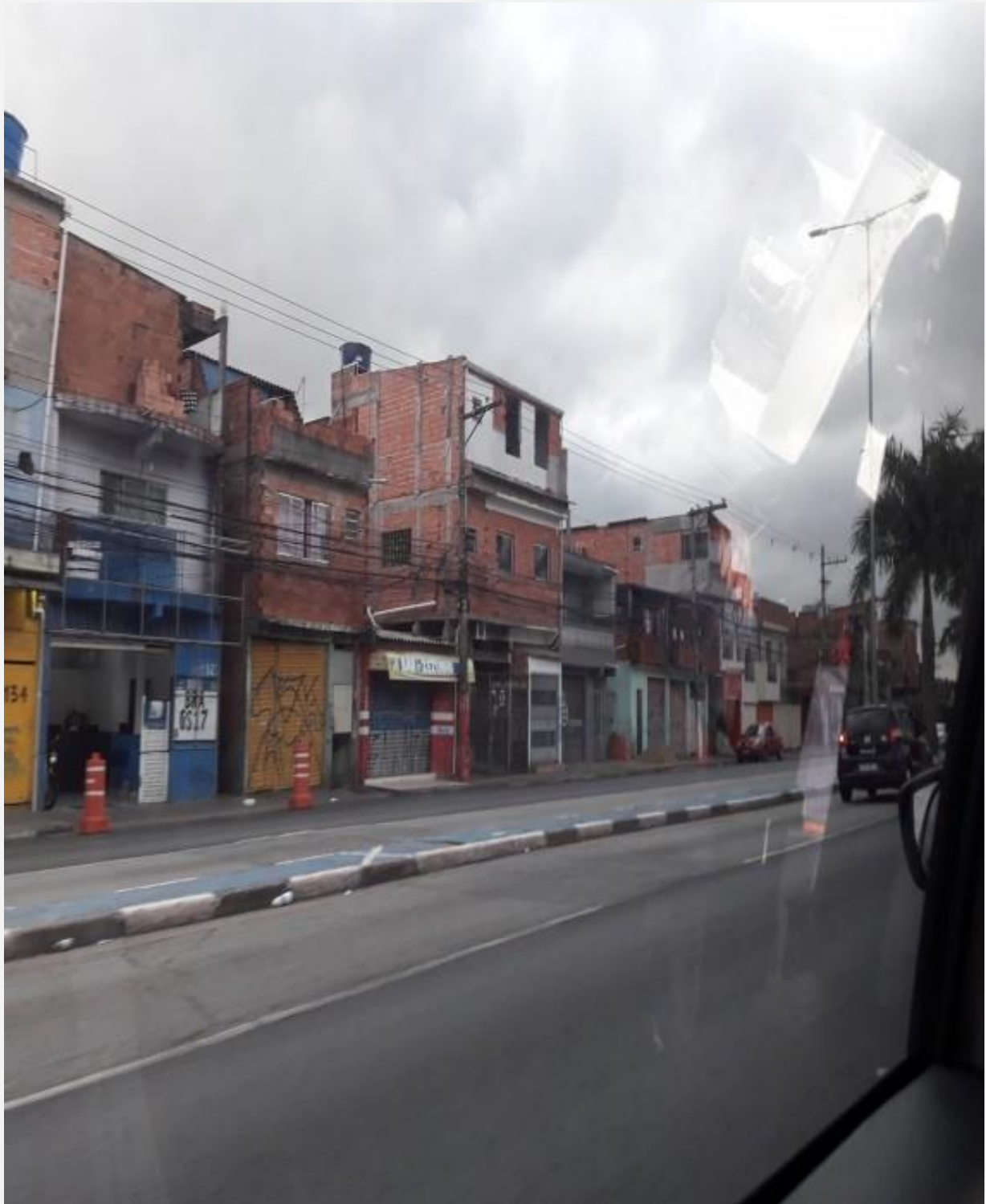
ÁREA PASSÍVEL DE INCÊNDIOS, DESLIZAMENTOS E ENXURRADAS
