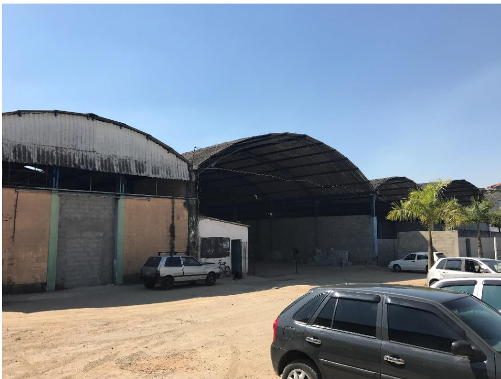
Figura 152 - Centro Unificado Ariston 03
