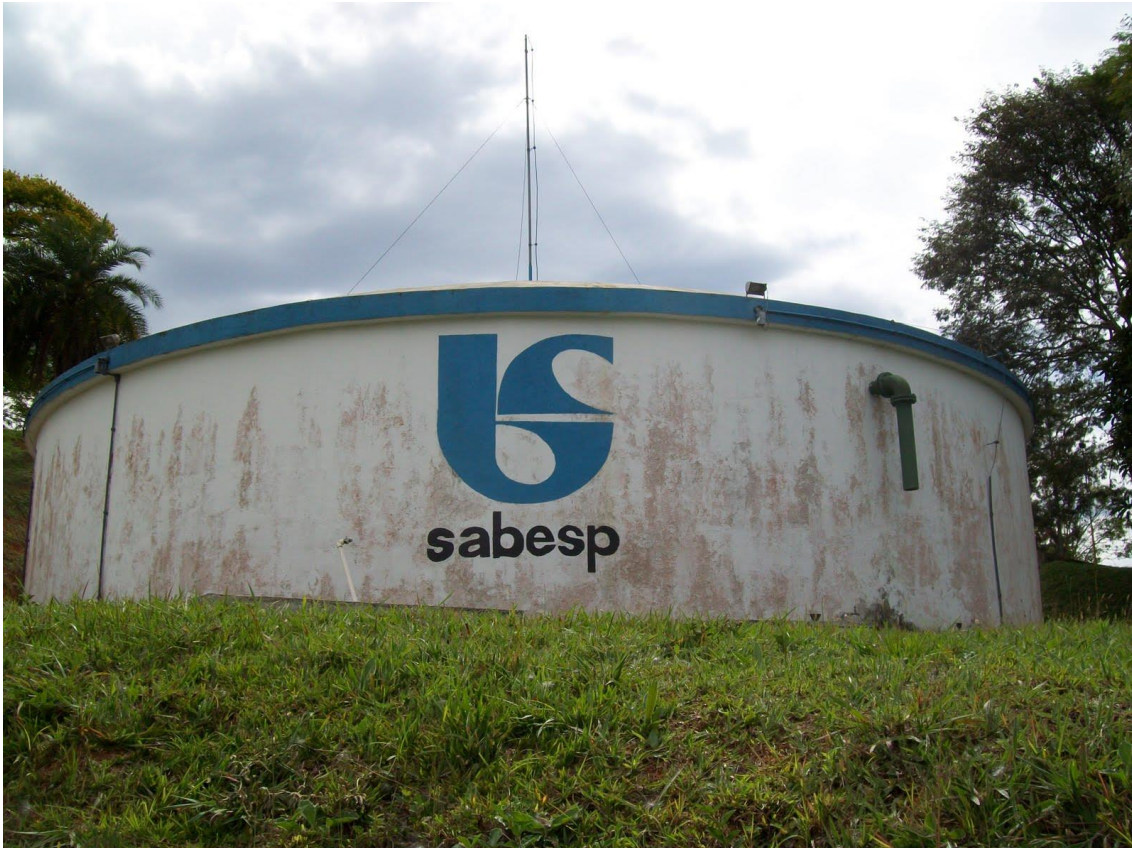
Figura 2 - Reservatório de Água em Carapicuíba
