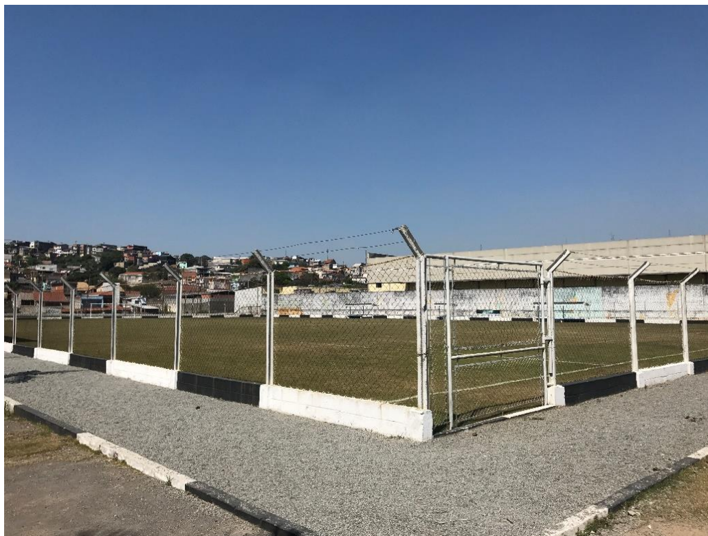
Figura 153 - Centro Unificado Ariston 04
