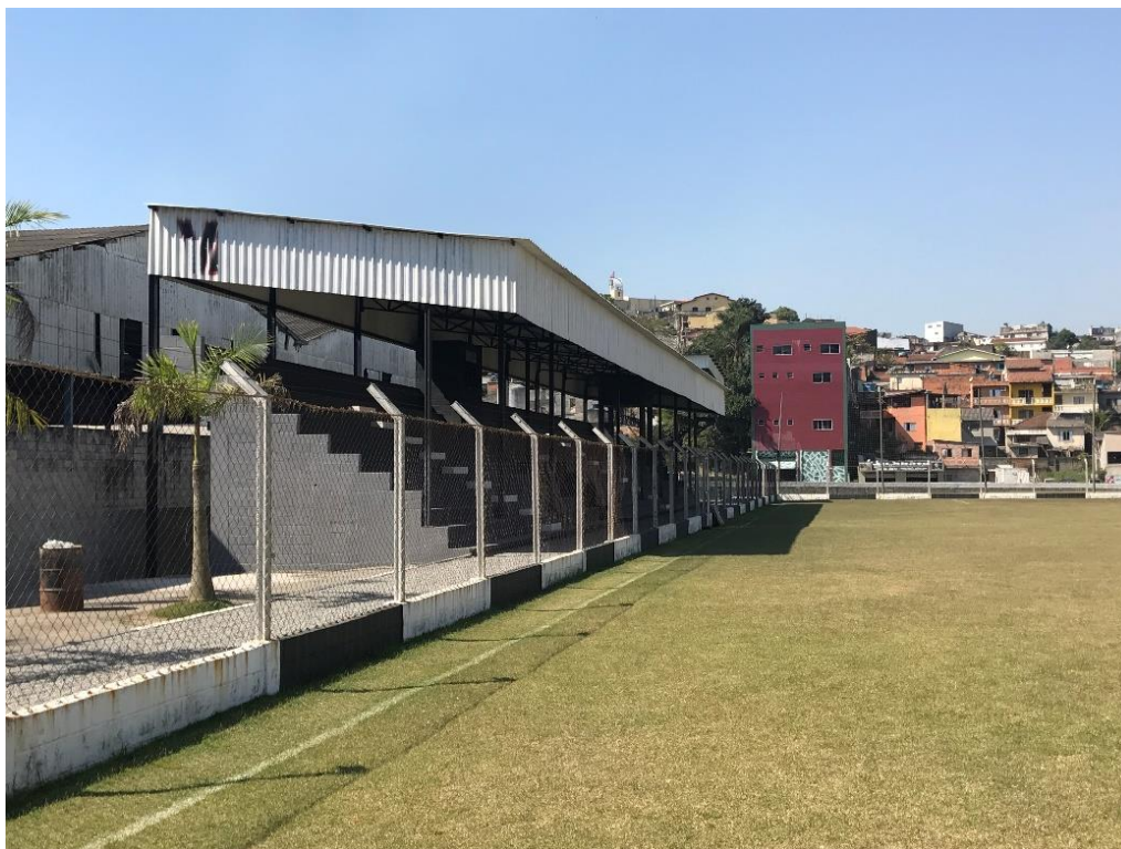
Figura 154 - Centro Unificado Ariston 05
