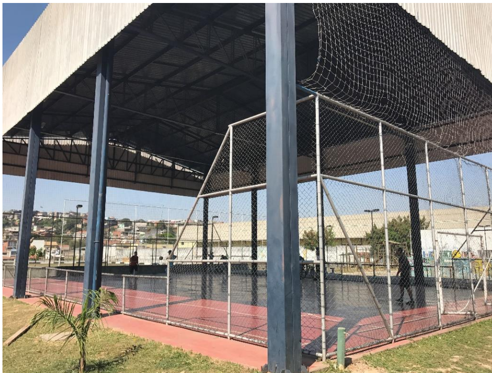
Figura 150 - Centro Unificado Ariston 01
