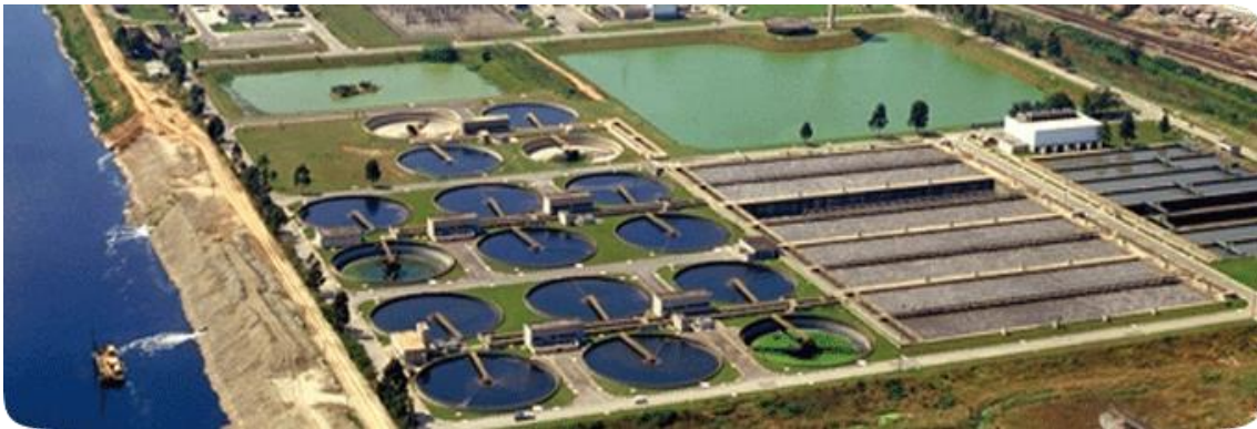
Figura 3 - Estação de Tratamento de Esgoto Barueri
