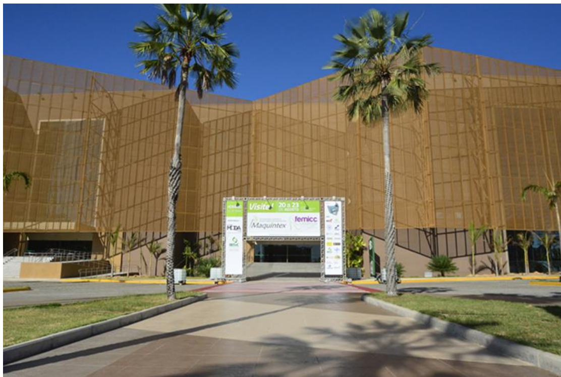
Figura 163 - Centro de Eventos do Ceará (Fortaleza/CE) 02
