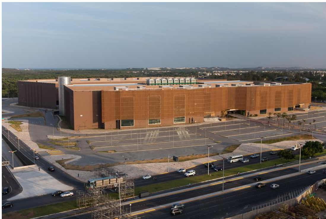
Figura 162 - Centro de Eventos do Ceará (Fortaleza/CE) 01
