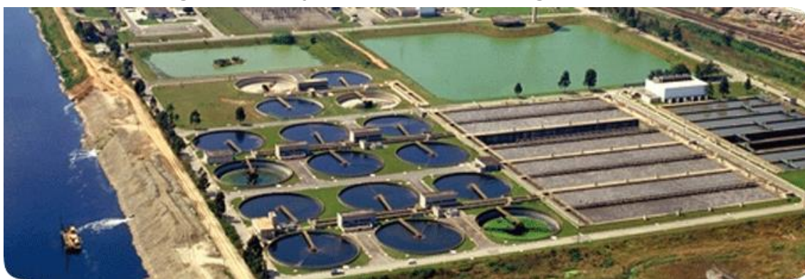
Figura 3 - Estação de Tratamento de Esgoto Barueri
