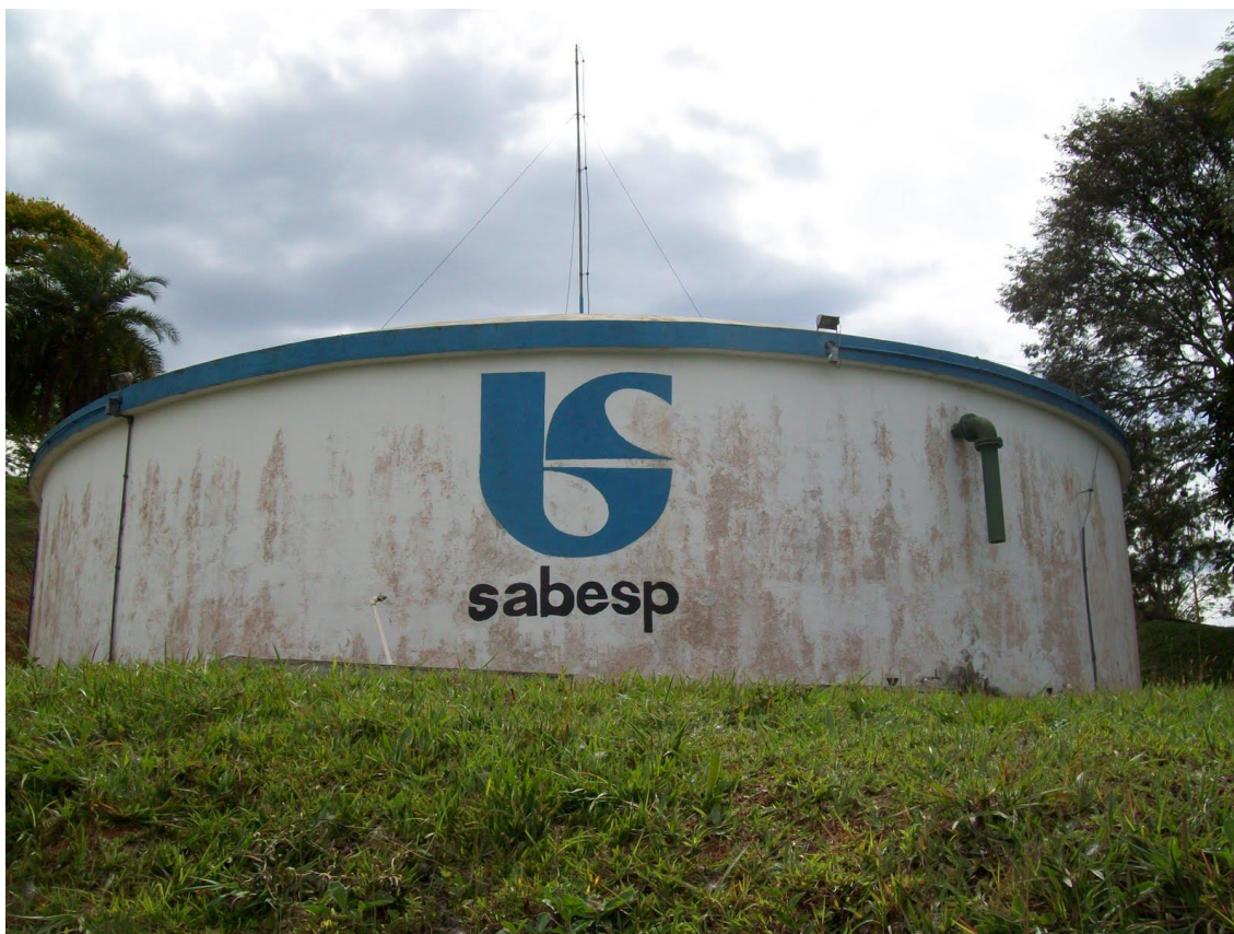
Figura 2 - Reservatório de Água em Carapicuíba
