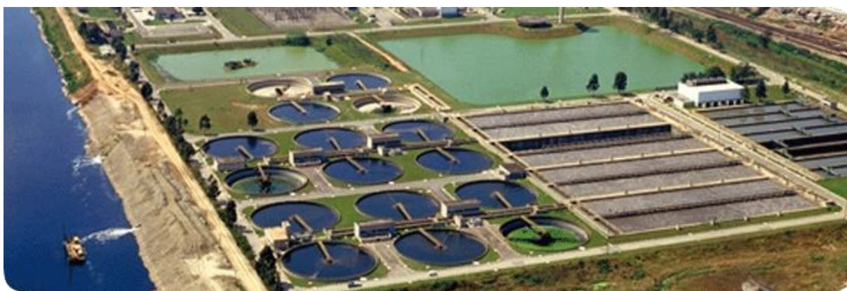
Figura 10: Estação de Tratamento de Esgoto Barueri
