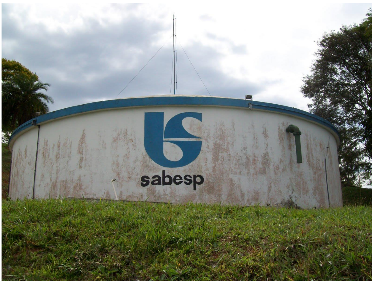
Figura 9 Reservatório de Água em Carapicuíba
